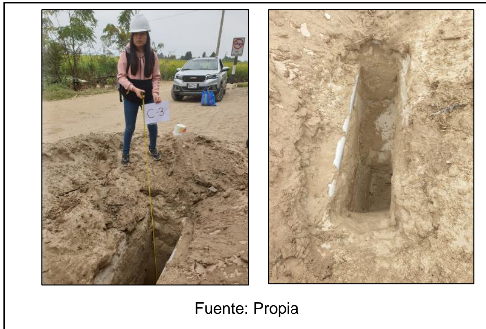
Figura 13. Excavación de Calicata 03 en el Tramo 01 (Conache – Campiña de Conache).
