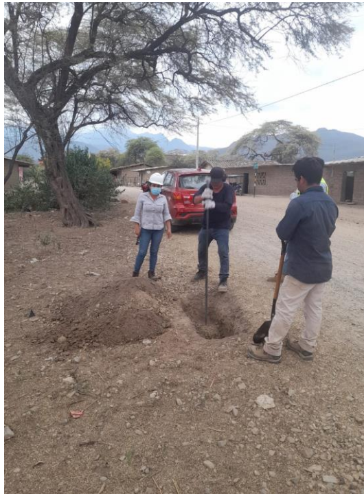
Figura 25. Excavación de calicata C06
