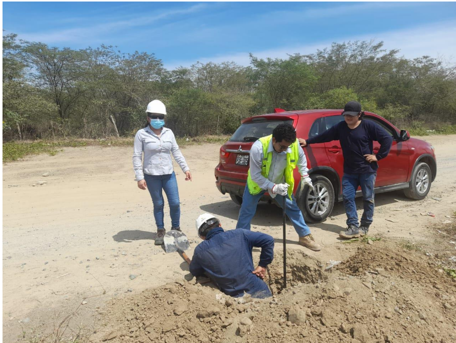
Figura 21. Excavación de calicata C01
