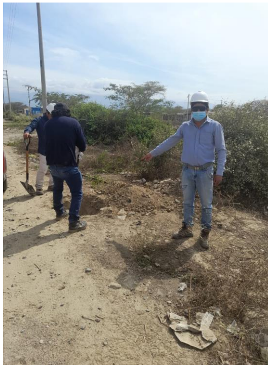
Figura 23. Excavación de calicata C04
