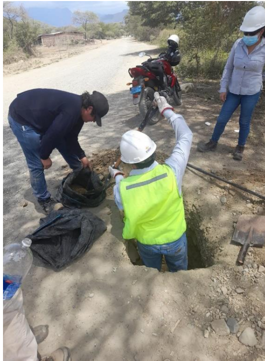
Figura 26. Excavación de calicata C08
