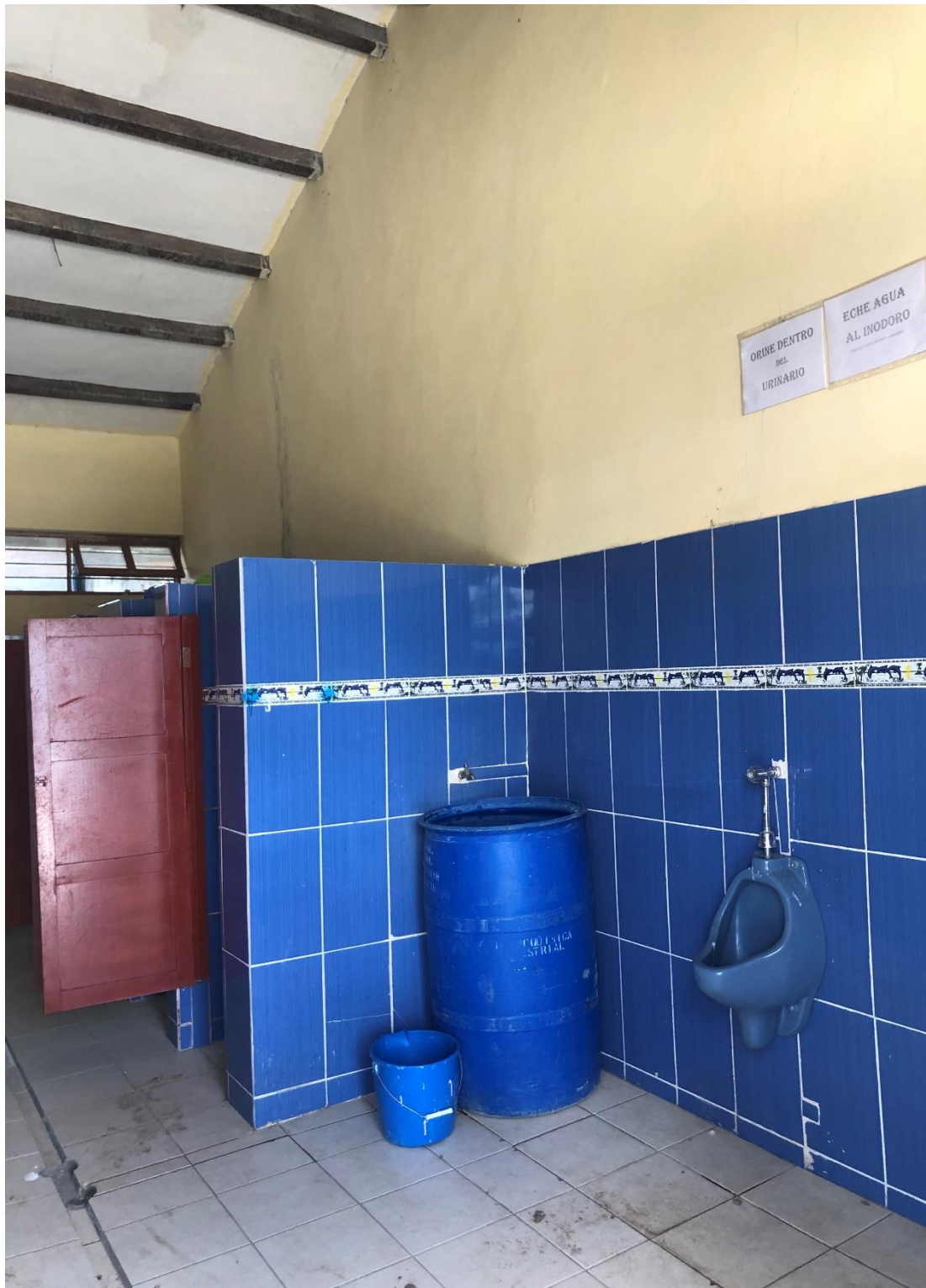
Figura N° 136 S.H. de Estudiantes – Varones, con Reservorio Provisional de Agua Potable por falta de Equipamiento Snitario, Pabellón N°6.
