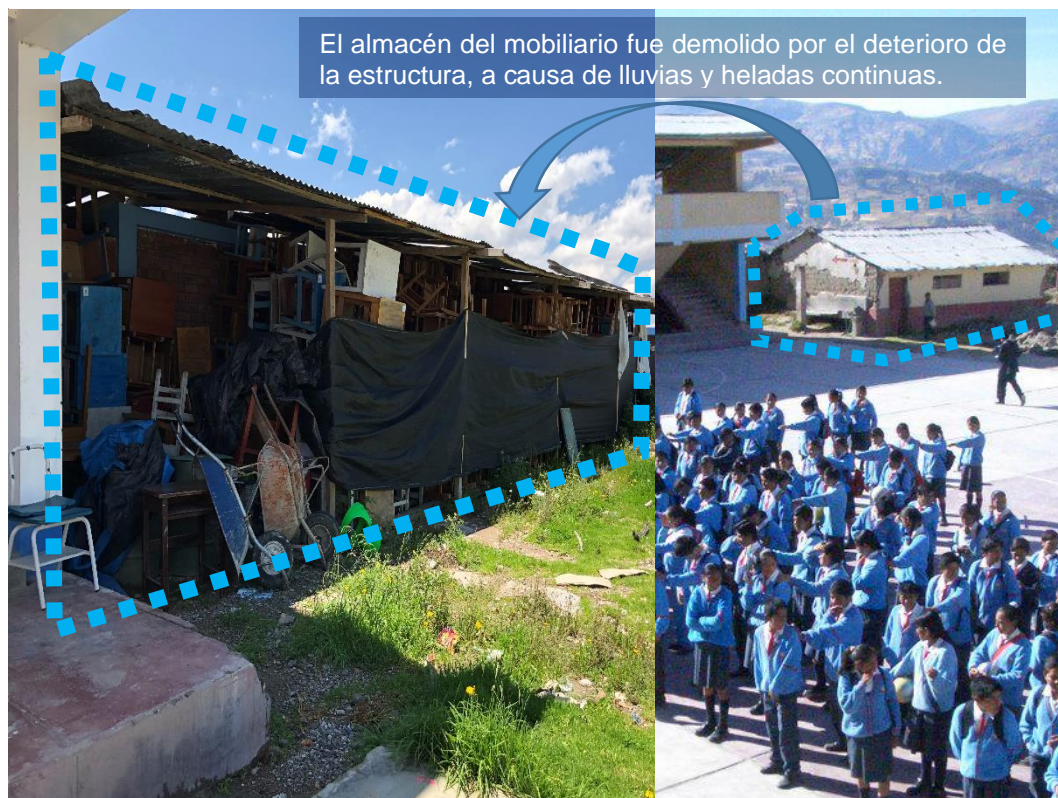
Figura N° 23 Almacén Provisional del Mobiliario Educativo, con Cobertura de Calamina.
