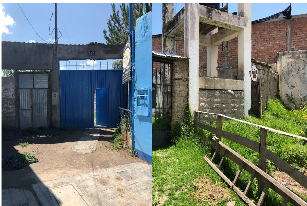
Figura N° 48 Cerco Perimétrico Antiguo, Jirón 9 de Diciembre, Zona Norte.
