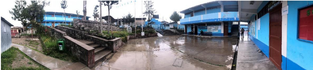
Figura N° 111 Vista Panorámica del Pabellón N°1 con lluvia.
