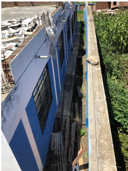
Figura N° 33 Pasaje con Acopio de Mteriales de Construcción del Pabellón N°4.
