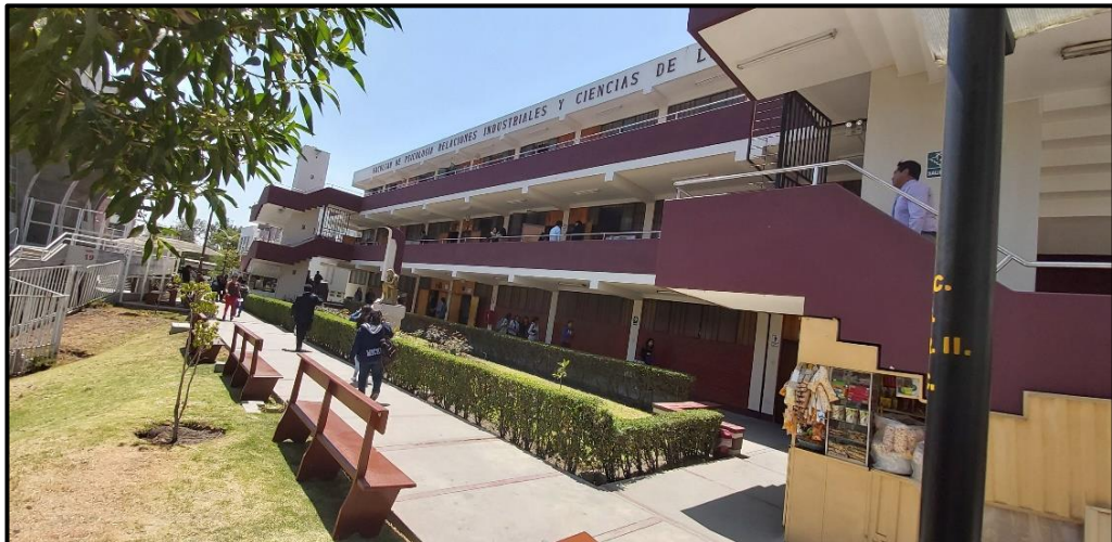
Figura 1 Vista frontal de la facultad de industrial de tres niveles. Fuente: Elaboración Propia.
