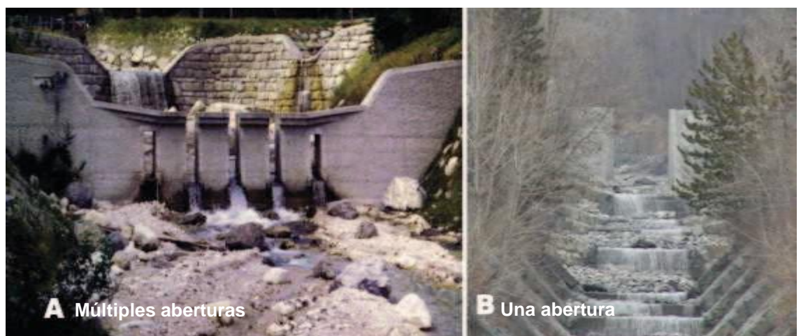
Figura 25: Presas de aberturas verticales (Slit-Dam)
