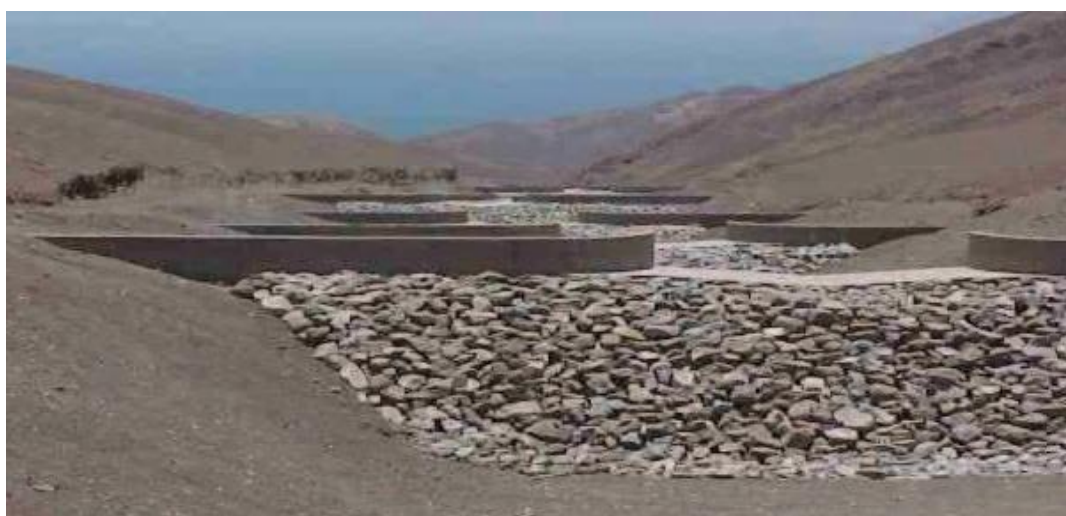
Figura 22 : Obras de almacenamiento construidas en las cercanías de la ciudad de Antofagasta, Chile
