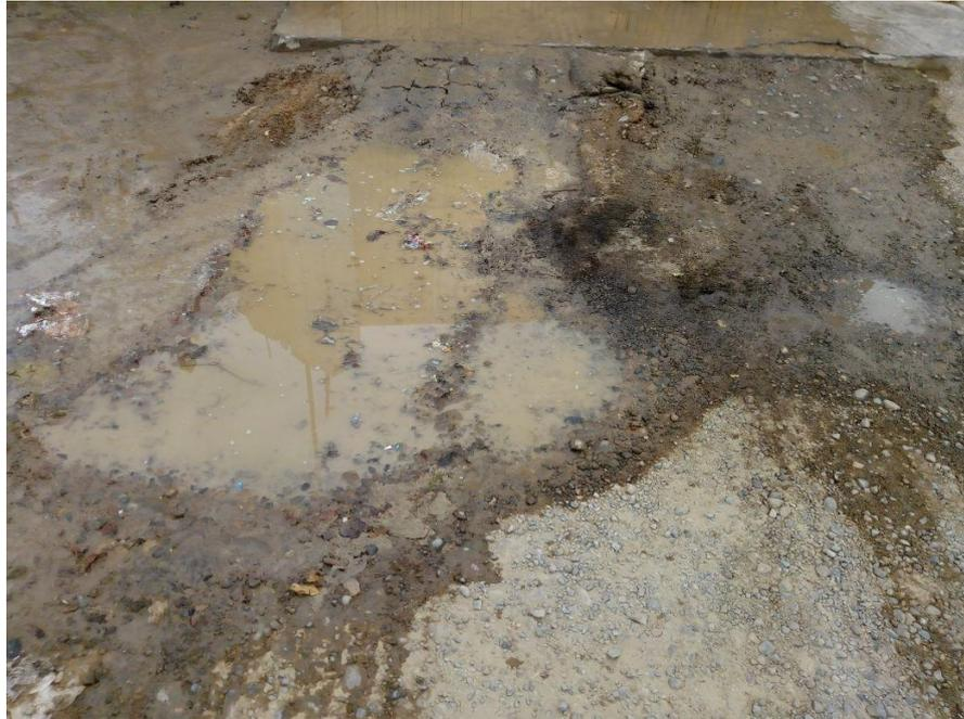
Imagen 5. Desintegración por baches progresiva 0+220.
