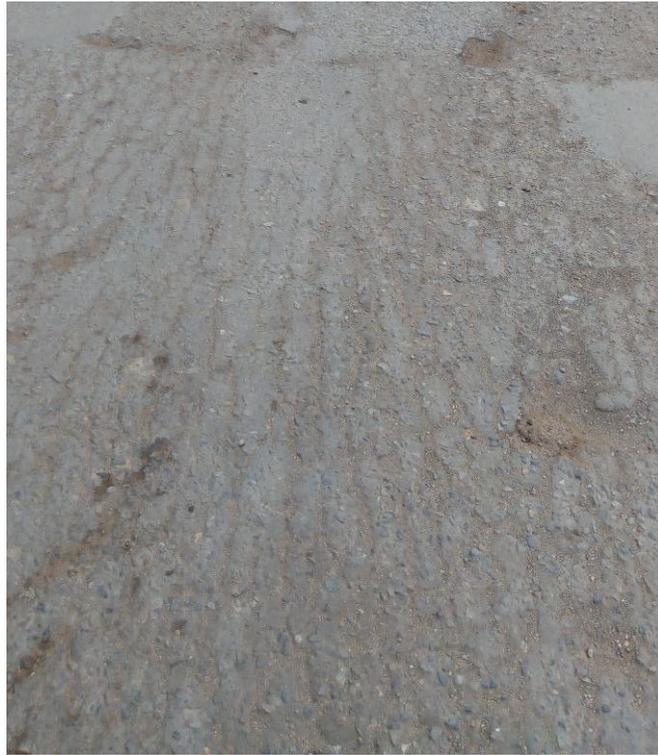
imagen 7. Fisura piel de cocodrilo progresiva 0+200.
