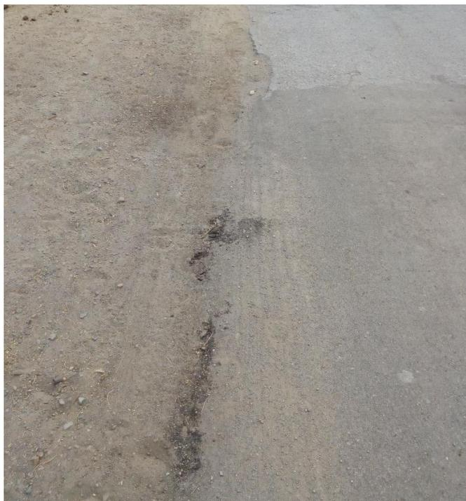
Imagen 6. fisuras de borde progresiva 0+240.
