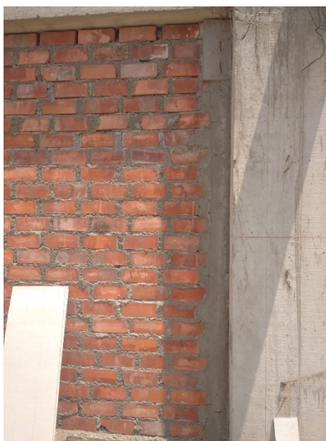
Figura 85 Desencofrado de columneta
