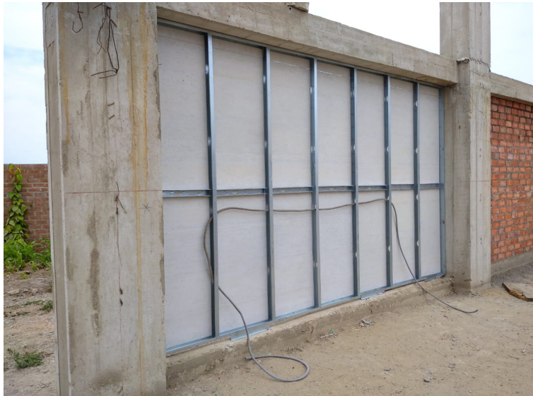
Muro Interno Drywall
