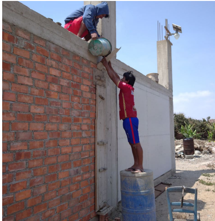
Figura 84 Vaciado columneta
