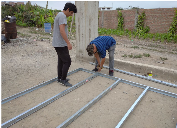
Figura 99 Instalación de riel y parante
