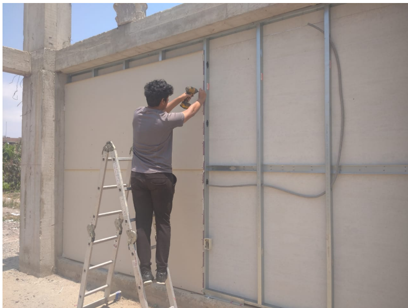
Instalación del Gyplac
