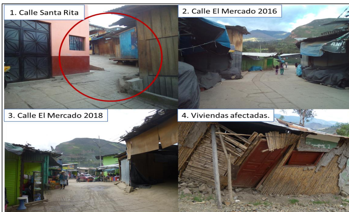
Ilustración 14. Calles y vivienda afectada por el deslizamiento pausado en la Ciudad de Huancabamba. Fuente: Imagen 1, 2, y 3 de elaboración propia (2016-2018), imagen 4 ( http://nioma.blogspot.com/2011/02/huancabamba-la-ciudad-que-camina-cuesta.html ).
