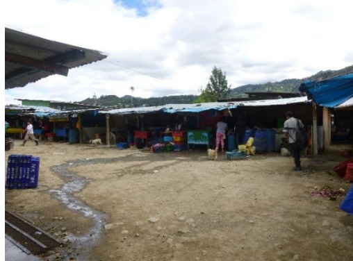
Ilustración 19. Terminal Pesquero de Huancabamba.
