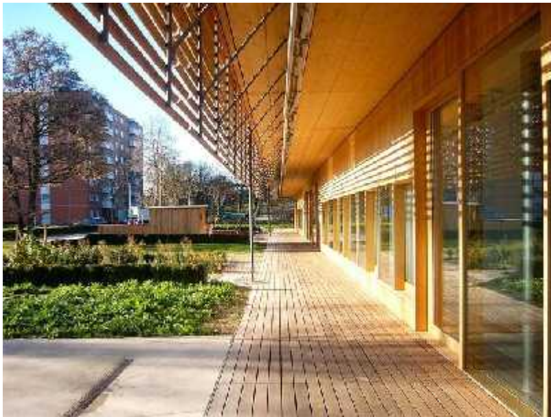
Imagen N°44: Corredores – Edificio del centro Rahab Basel
