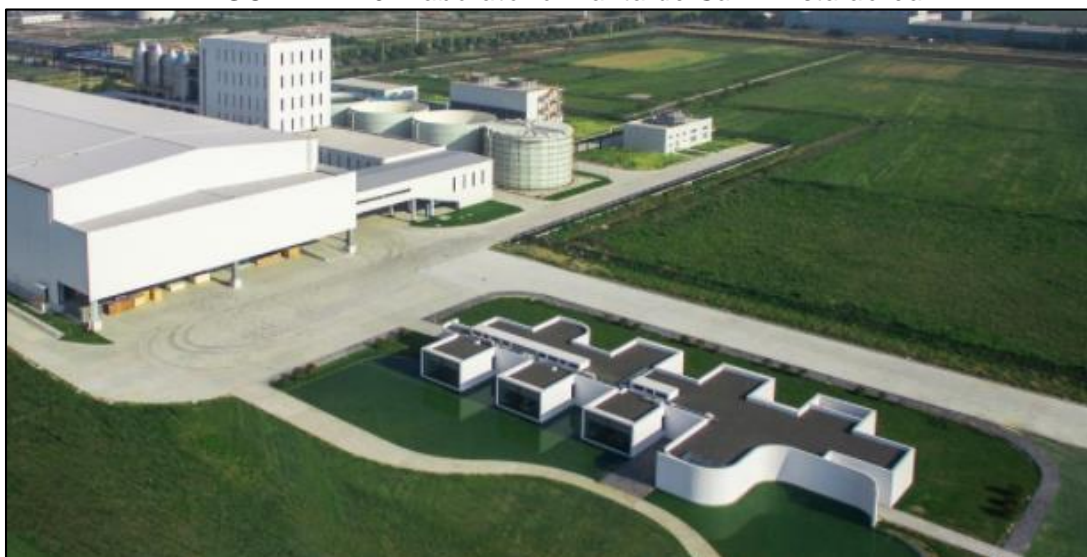
FIGURA N° 40: Laboratorio Planta de Sal – Vista aérea
