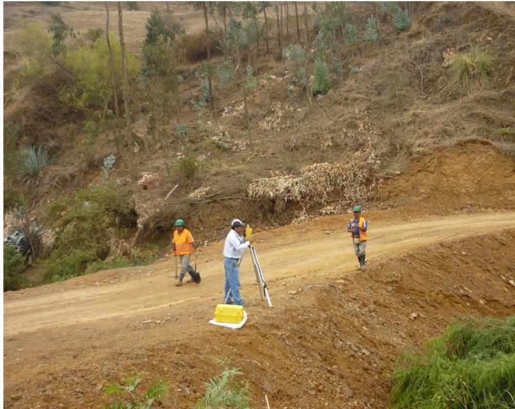
*FIG. 28: Levantamiento Topográfico de la Carretera.*
