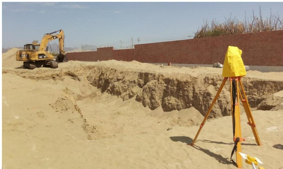
FIG. 30: Trazo de Reservorio y Excavación en Talud con estación total Trimble. (1:1.5).
