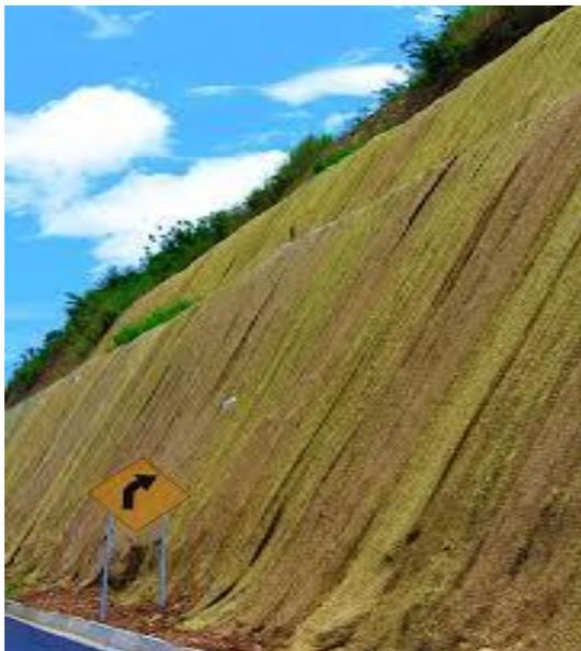
*FIG. 27: Talud y Banqueta terminada*
