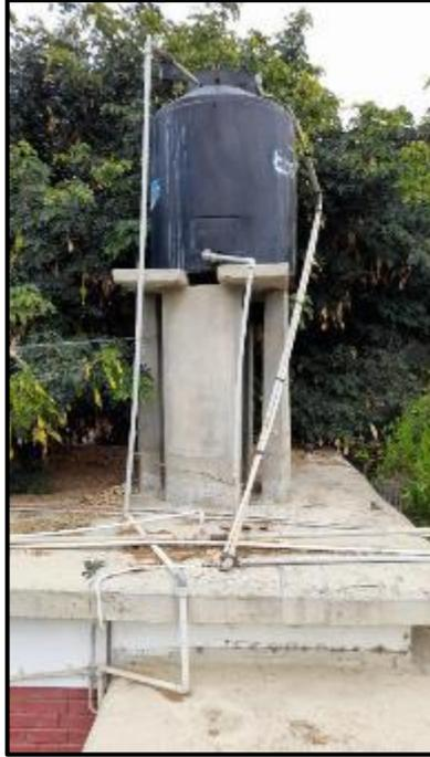
Tuberías de distribución de agua existentes. El material es de fierro galvanizado y se encuentran en estado de oxidación.
