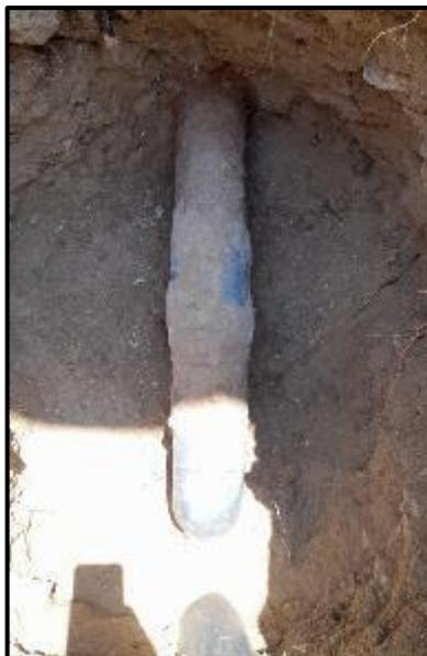
Tubería del sistema de desagüe. El material es de fierro fundido.
