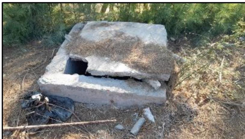
Cajas de paso desprotegidas y deterioradas.
