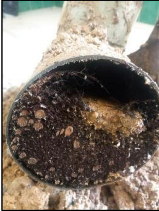
Presencia de raíces en el interior de líneas del sistema de desagüe.
