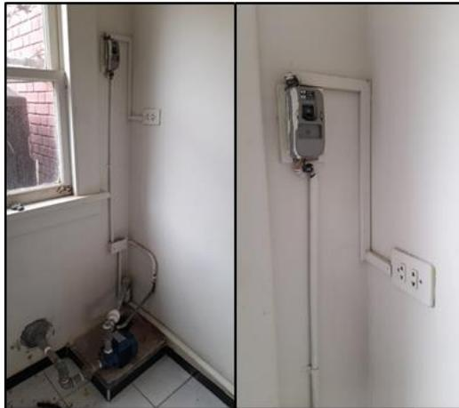
Instalación no recomendada de Breaker de electrobomba (conectada en tomacorriente).
