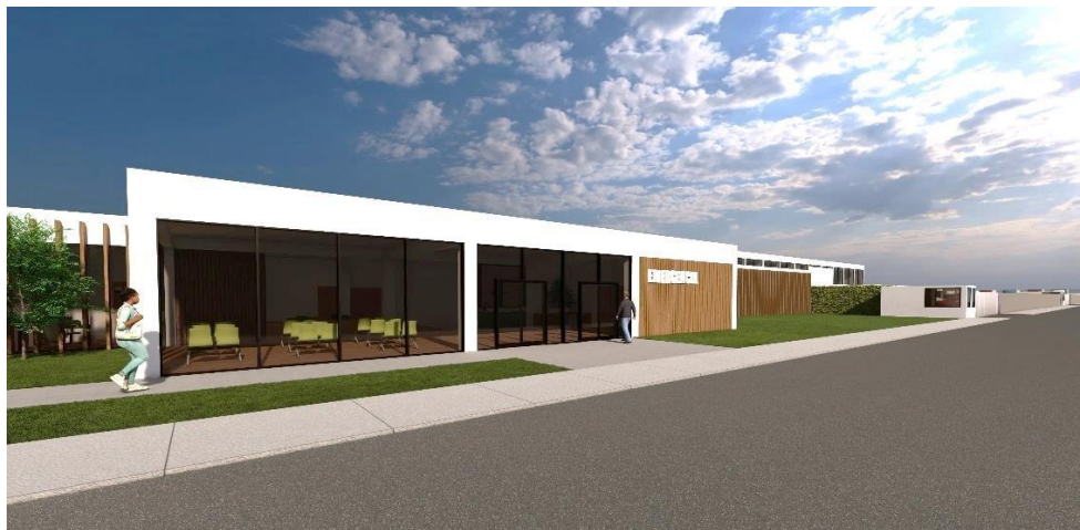
Imagen 55: Accesos de emergencia – Calle 16
