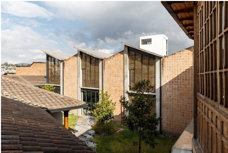
Imagen 10: Espacio interior del Centro Ambulatorio San Lázaro
