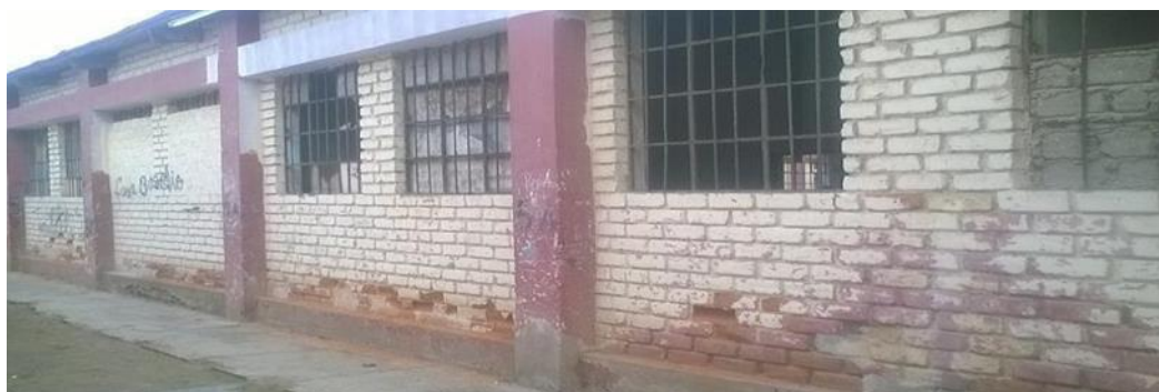
FIGURA N° 33: Infraestructura externa del centro educativo politécnico
