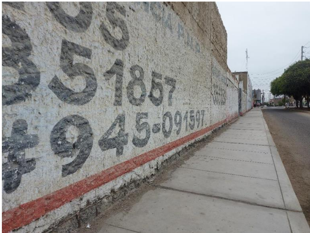
FIGURA N° 115: Vista del jirón San Pedro hacia el terreno
