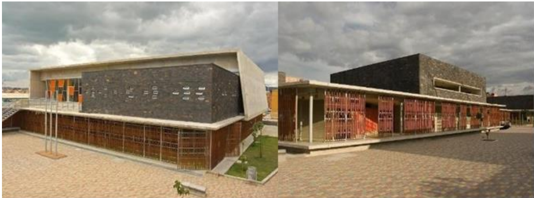
FIGURA N° 17: Vista fachada I.E. Gerardo Molina
