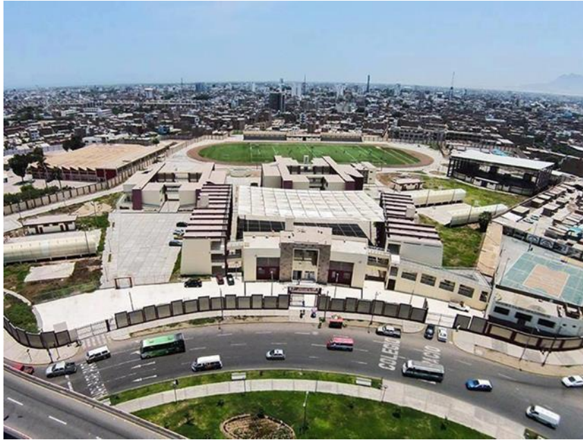
FIGURA N° 24: Vista aérea de la I.E. G.U.E
