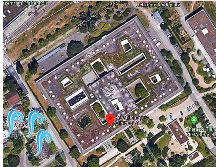
Ventilación del centro Rehab Basel
