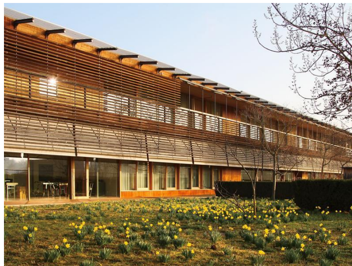
Celosías de lamas de madera en Rehab Basel
