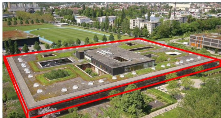
Forma del Centro Rehab Basel
