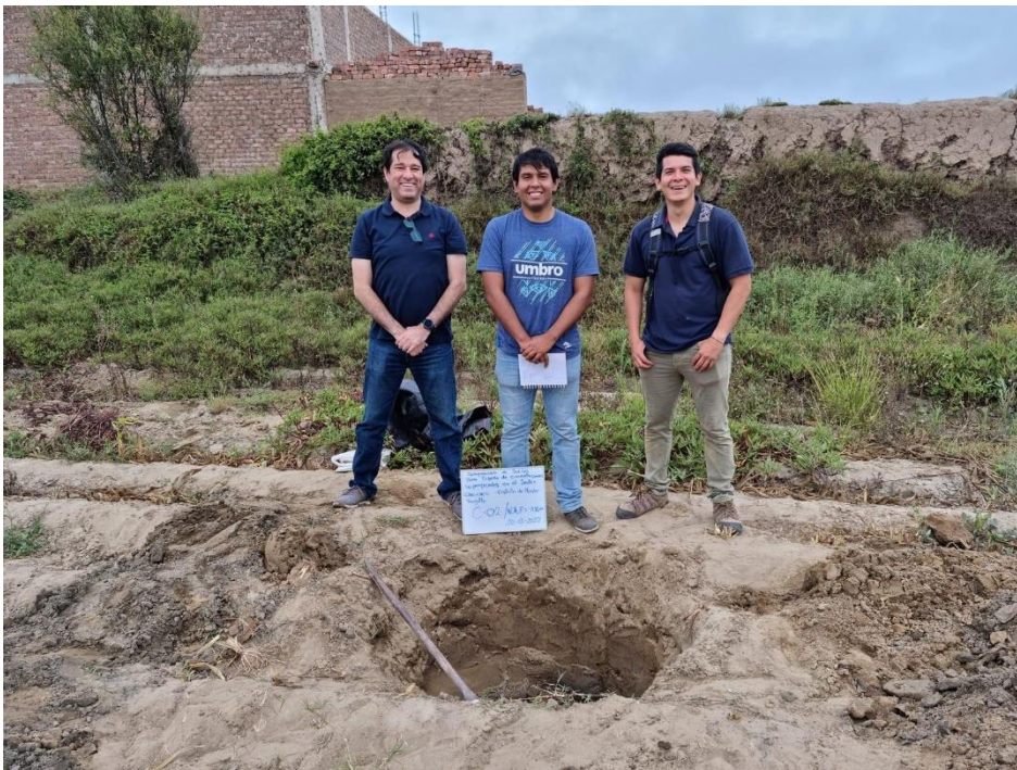
Realización de la Calicata 02
