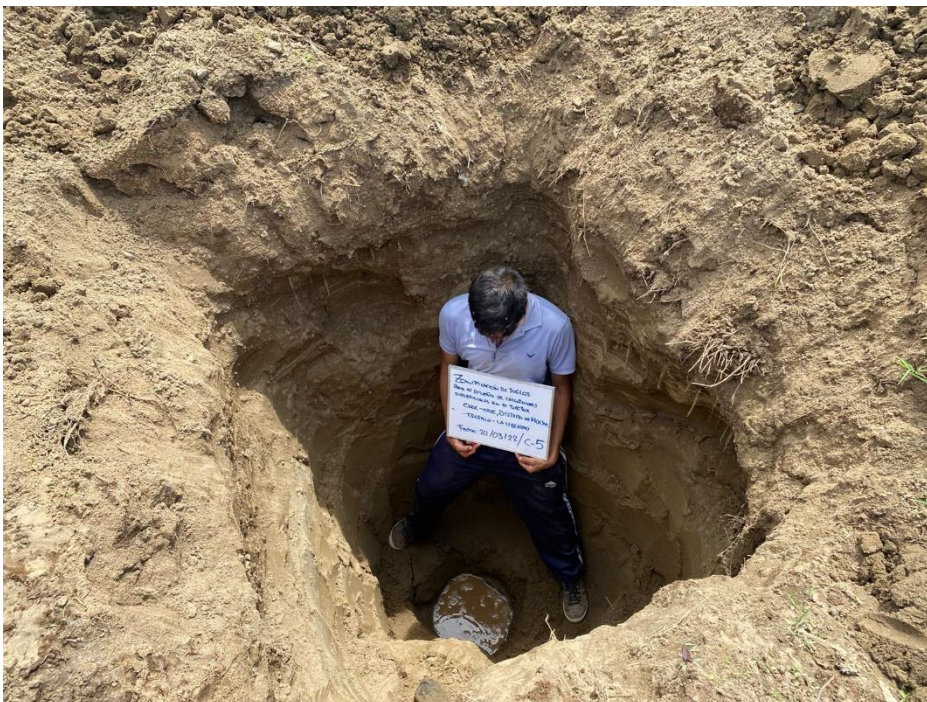
Realización de la Calicata 05
